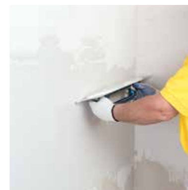
Forarbejdning med Ytong Multipor Kalkpuds
